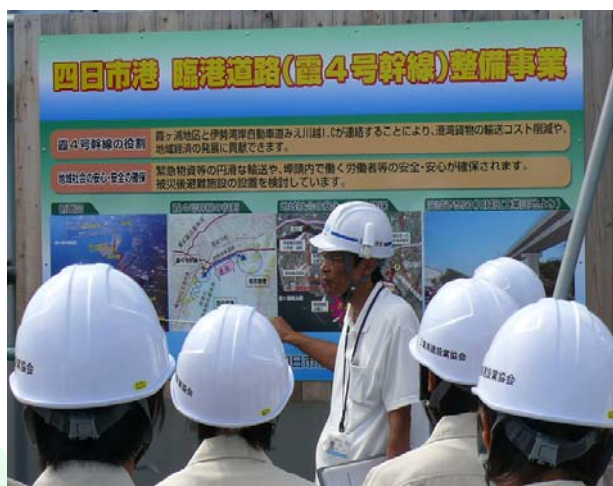
カルバートボックス上部施工現場
