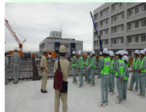
三重大学病院外来・診療棟新営その他工事 現場②
