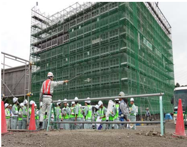
朝明川橋・下部工工事現場①
