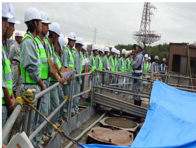
朝明川橋・下部工工事現場②
