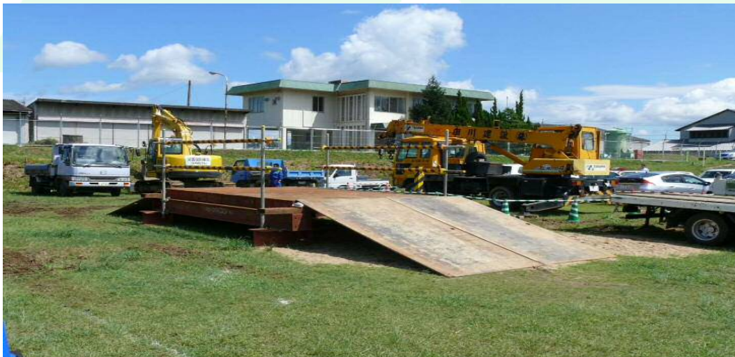
応急仮設橋設置の様子
