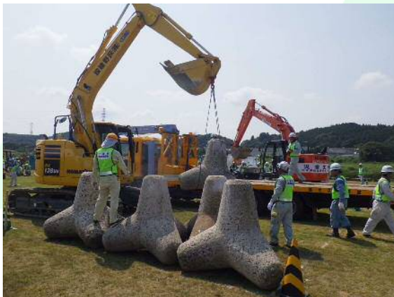
根固めブロック設置訓練
