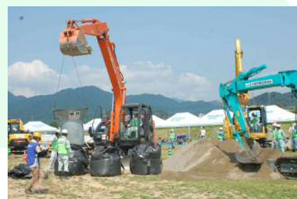
大型土嚢作成・設置訓練
