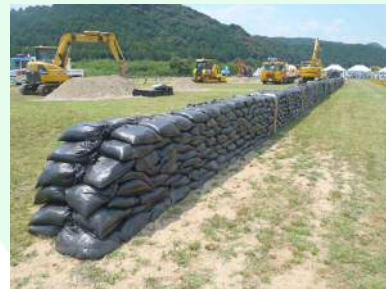
大型・小型土嚢設置状況
