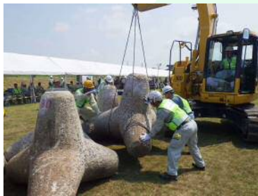
根固めブロック設置訓練
