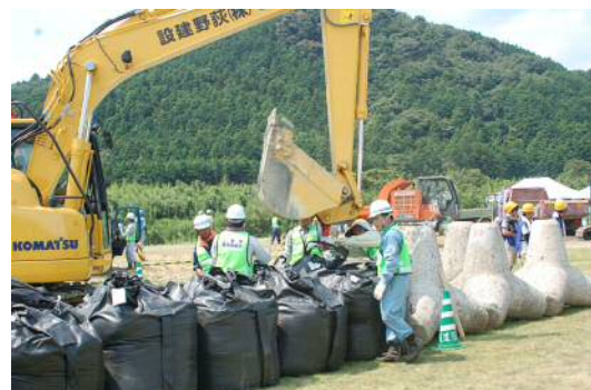
大型土嚢作成・設置訓練
